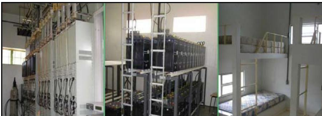
FIGURA 17 – ESTRUTURA PRATÔES DAS ESTAÇÕES DA EMBRATTEL NO TRONCO PORTO VELHO Á MANAUS.
